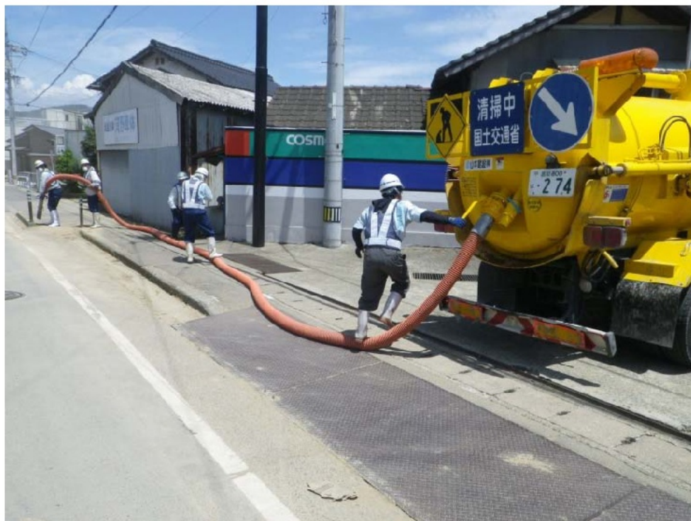
作業中の側溝清掃車
