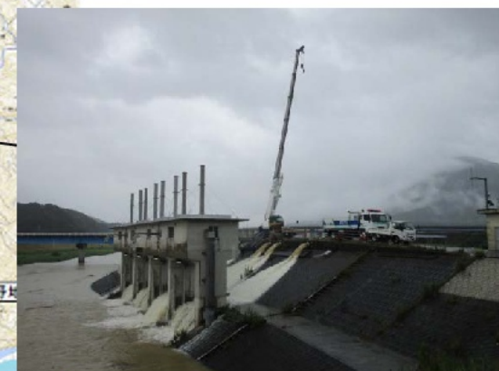
都谷川樋門排水状況
