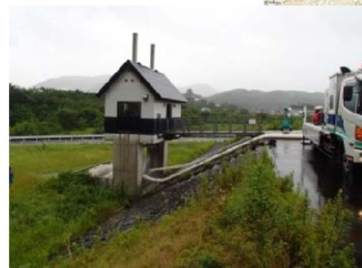
武田川樋門排水状況
