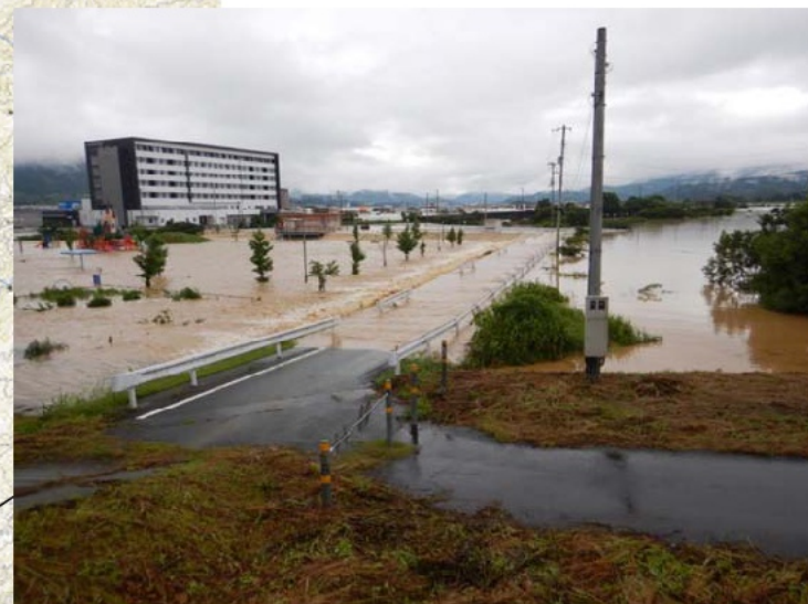
二線堤越流状況(7日11時頃)
