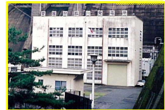
肱川発電所 (愛媛県公営企業局)
