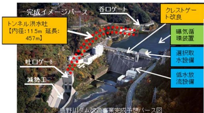
鹿野川ダム貯水位低下を有効にする改造計画のイメージ図
