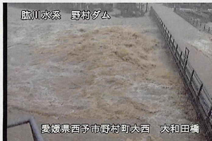
野村ダム下流の大和田橋の状況
