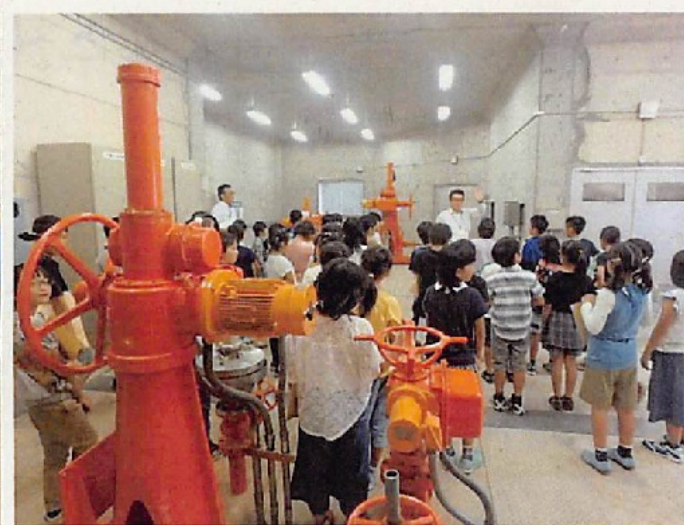
ダム堤体内設備の見学
