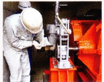
放流設備の点検・補修
