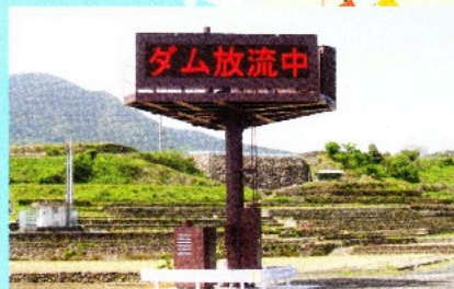
⑦ ダム放流電光表示板
