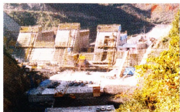
ダム建設工事(ダムサイト)
