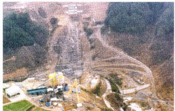
ダム建設工事(全景)
