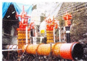
放水管の設置工事
