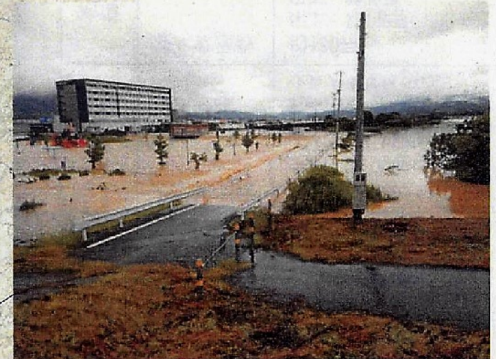
二線堤越流状況(7日11時頃)
